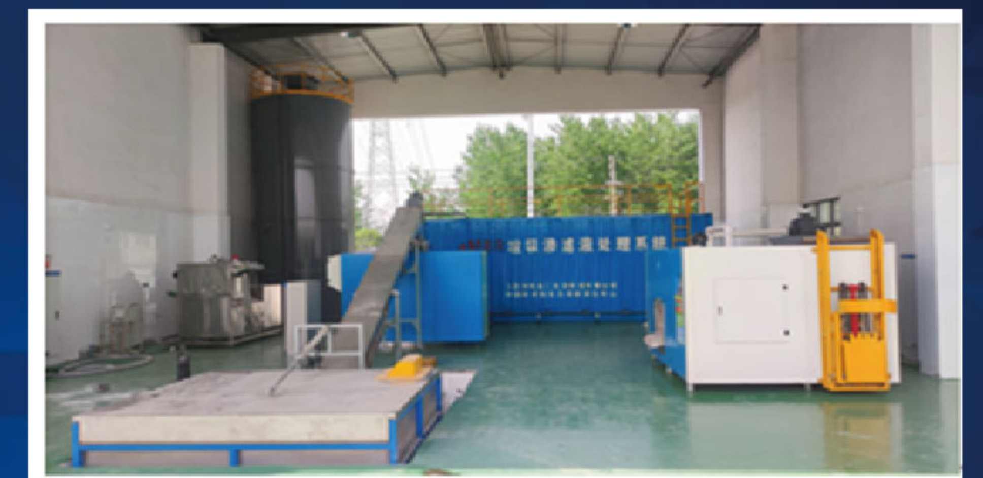
某市垃圾转运站污水-垃圾处理设施全貌
